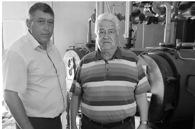
■ В котельной МБУЗ ЦРБ.
