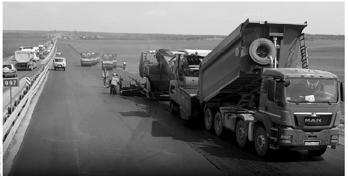
Работы на трассе уже начались
