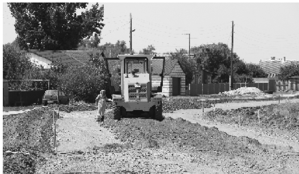
Строительство дороги в х. Наумове.
