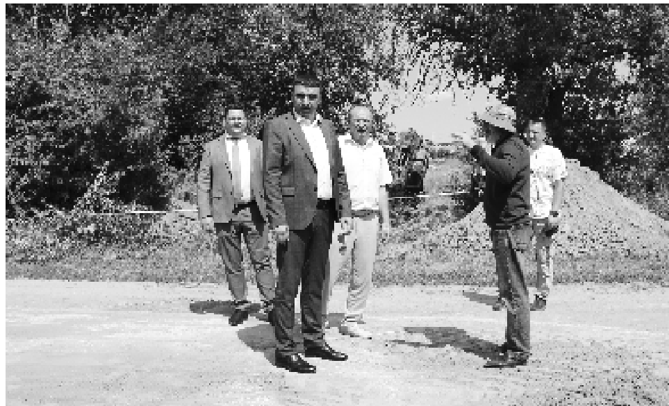
Участники группы осматривают ведение водопровода в сл.Петрово.
