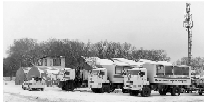
Мобильная станция связи. Фото: Илья Сидоркин / ИА «Авангард»
