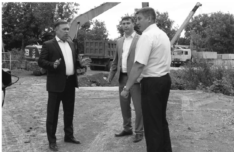
Работы по расчистке рек, озеленению и лесовосстановлению в рамках нацпроекта «Экология» идут полным ходом
