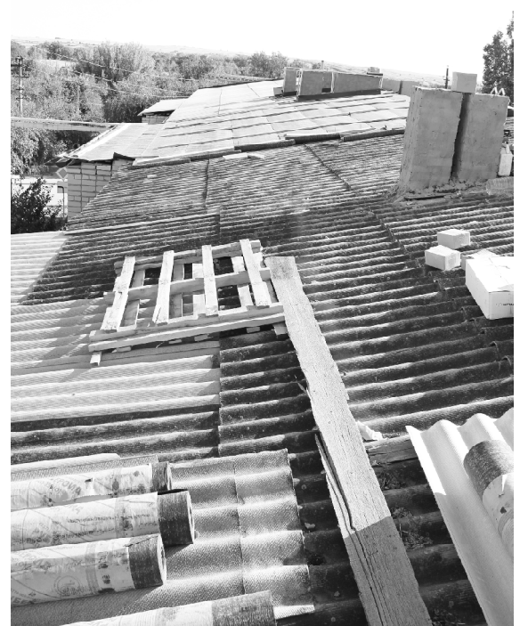
■ На снимке: крыша дома во время ремонта.
